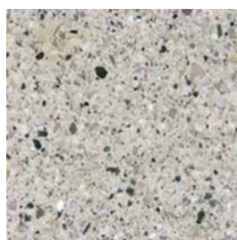
HPC com granito acabamento polido
